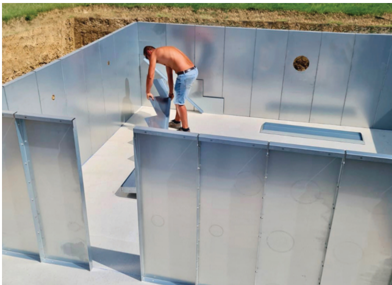
Piscine enterrée en panneaux EasySteel d'une hauteur de 1,50 m, prête au bain en 2/3 jours - aucune maçonnerie, pas de temps de séchage.
