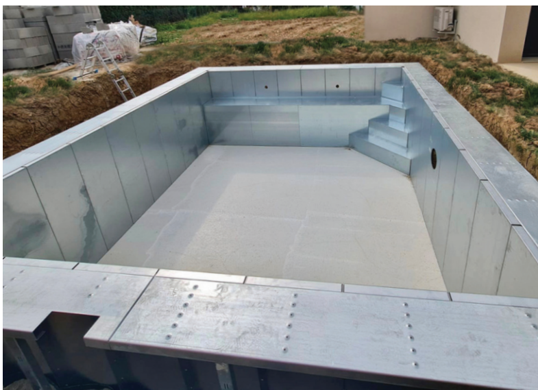
Piscine autoportante EasySteel sans ceinture de béton - possibilité de poser un dallage en pierre ou monter une terrasse en bois sur les supports margelle - escalier d'angle banquette.
